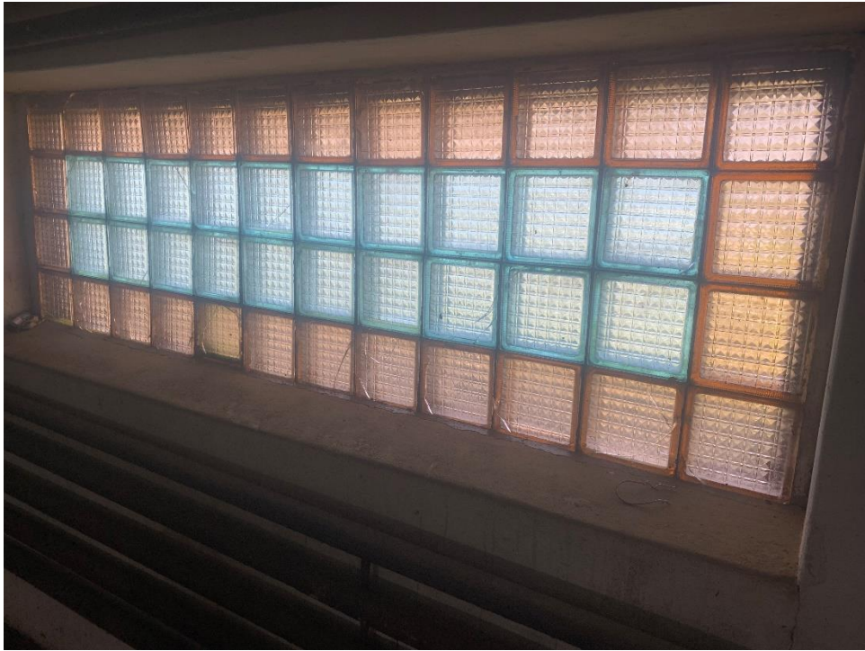
Ryc. 4. Okno od strony zachodniej (fot. E. Urbaniak)
